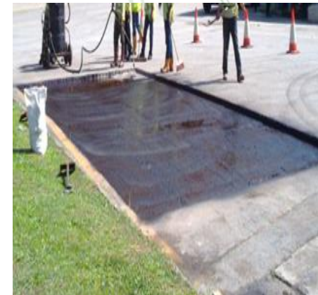
(c) Spraying Primer Coat
